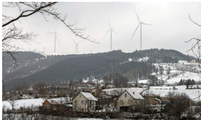
Ветряные турбины на ветропарке «Selace» в Байгоре, Косово, ежегодно вырабатывают 320 гигаватт-часов электроэнергии. Косово, традиционно зависящее от угля, активно привлекает иностранные инвестиции для перехода на более устойчивые источники энергии. GETTY IMAGES
