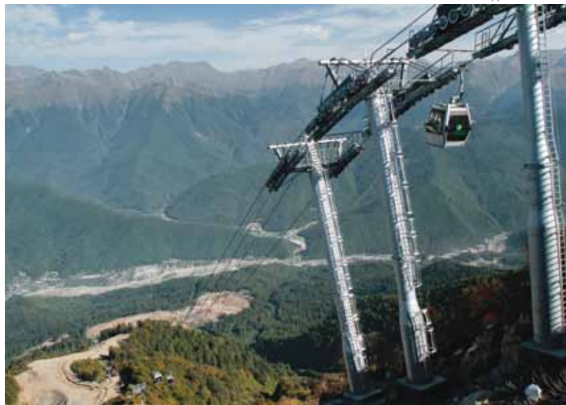
Строительство подъемника вблизи Сочи – места проведения Зимних Олимпийских Игр 2014 года. Игры должны привлечь тысячи туристов на Кавказ – регион, пытающийся оживить свою экономику.
